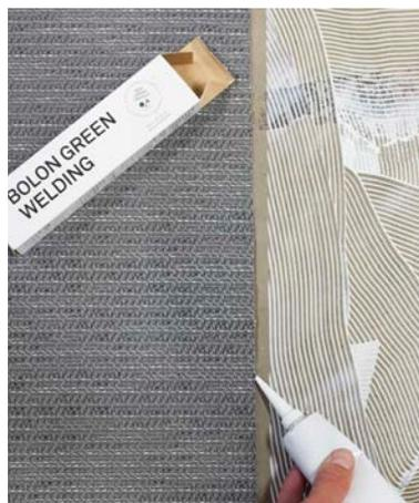
7. Fügen Sie Bolon Green Welding entlang der Querschnittsfläche der Platte Blechs hinzu. Vermeiden Sie ein Austreten auf die Oberfläche des Bodenbelags.
