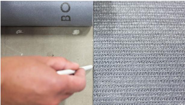
3. Rollen bzw. falten Sie die erste Bahn. Markieren Sie die Lage der Stoßstelle auf dem Untergrund.
