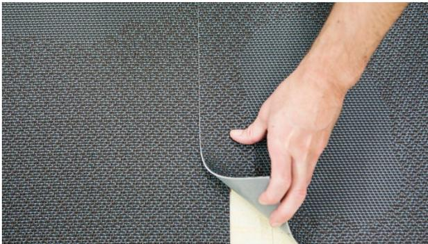
1. Überlappen Sie 2 Bahnen um 4 cm und schneiden Sie sie zusammen durch. Achten Sie darauf, dass Sie nicht in die großen Punkte schneiden.
