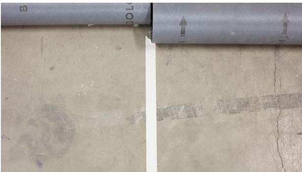
4. Rollen bzw. falten Sie die angrenzende Bahn und kleben Sie Abdeckband mittig über die Stoßlinie auf den Untergrund.
