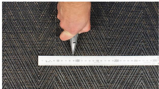
1. Überlappen Sie 2 Bahnen und ordnen Sie sie so an, dass das sich wiederholende Muster ca. 180 mm misst. Schneiden Sie die beiden Bahnen bei 90 mm des Streifens zusammen durch.
