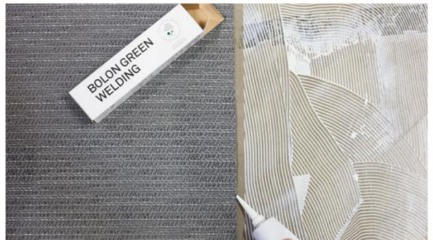
7. Fügen Sie Bolon Green Welding entlang der Querschnittsfläche der Bahn hinzu. Vermeiden Sie ein Austreten auf die Oberfläche des Bodenbelags.
