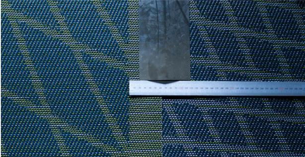
Legen Sie die Bahn mit der grünen Kante nach oben und überlappen Sie sie über die ganze Bahnbreite. Schneiden Sie die Kante so, dass 2 cm als grüner Streifen sichtbar bleiben.
