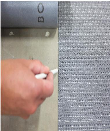
3. Rollen bzw. falten Sie die erste Platte. Markieren Sie die Lage der Stoßstelle auf dem Untergrund.
