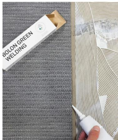
7. Fügen Sie Bolon Green Welding entlang der Querschnittsfläche der Platte Blechs hinzu. Vermeiden Sie ein Austreten auf die Oberfläche des Bodenbelags.
