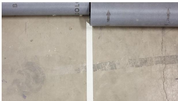
4. Roulez/pliez sur la feuille adjacente et mettez du ruban de masquage sur le sous-plancher le long du centre du raccord.
